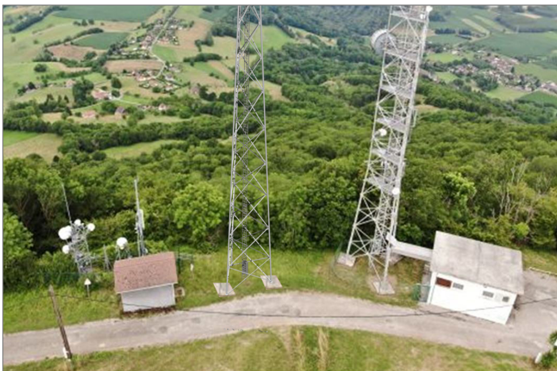
Photographie après travaux
