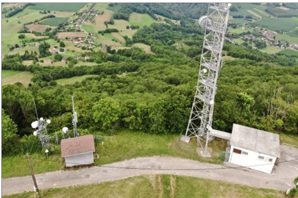
Photographie avant travaux
