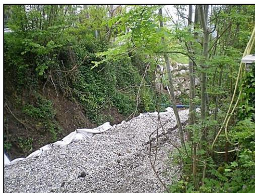
Le chemin qui avait une largeur de plus de 6,00 mètres suite à l'effondrement progressif du talus a retrouvé son gabarit initial de 3,00 mètres. Le talus va être engazonné et replanté
