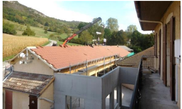
Côté ouest, après couverture
