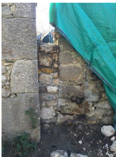
2 ème étape : Du côté de la route, on bouche l'espace
