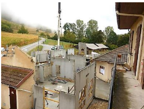
Côté ouest, avant la couverture
