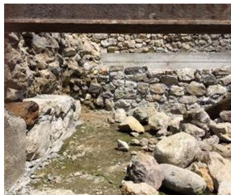
Le commencement du mur du fond et le renforcement du mur côté route
